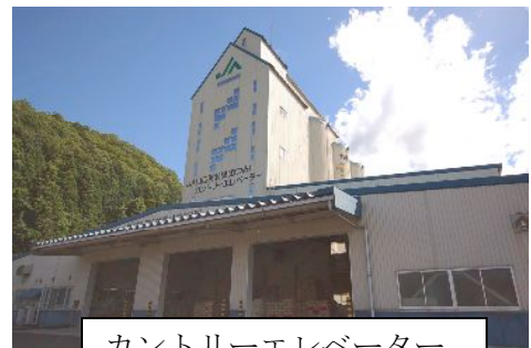
カントリーエレベーター
