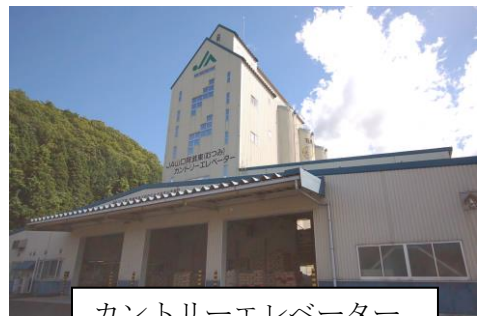
カントリーエレベーター
