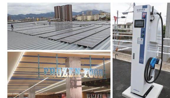
▲LED照明で明るい店内と電気自動車の急速充電器。
